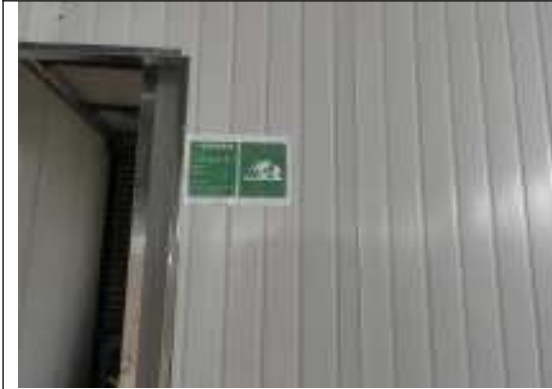
一般固废间照片
