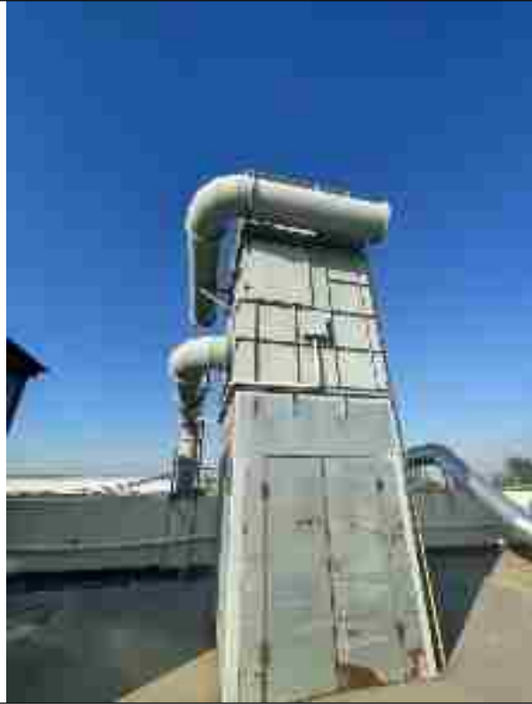
废气处理设施（袋式除尘器）+DA003 排气筒
