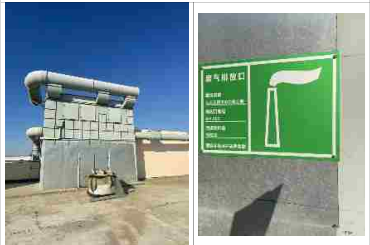
废气处理设施（袋式除尘器）+DA002 排气筒
