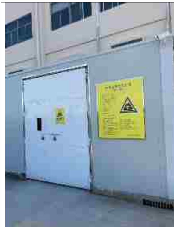
危废仓库门口标识牌
