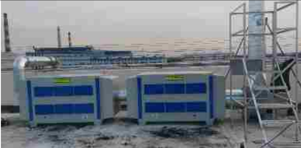
废气处理设施（袋式除尘器）+DA003 排气筒
