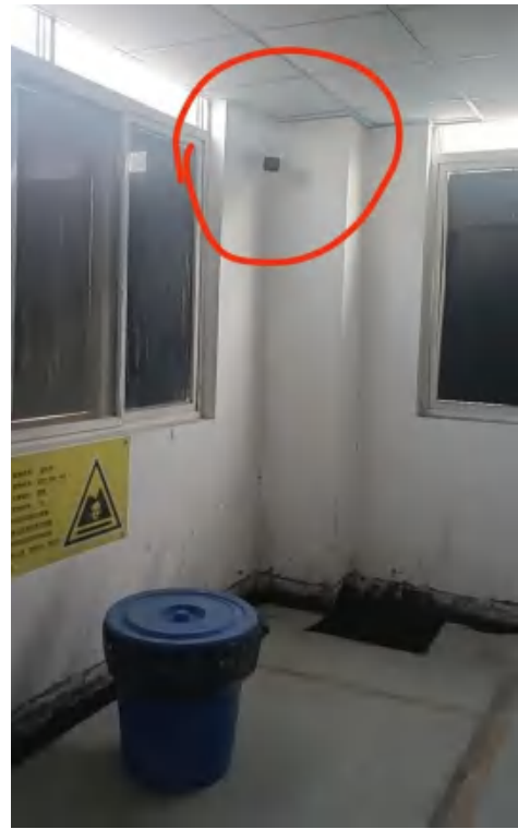
危废仓库内部设置监控
