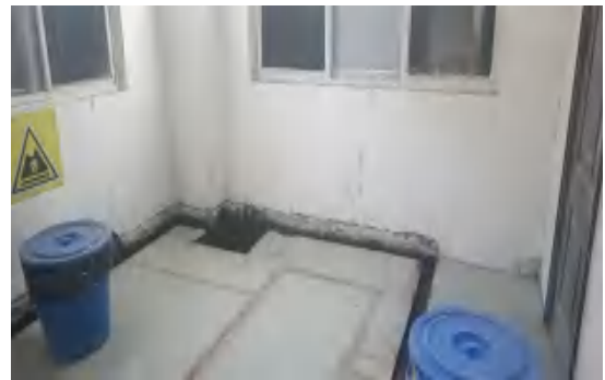
危废仓库内部设置导流槽与收集池
