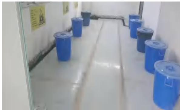
危废仓库内部设置导流槽与收集池
