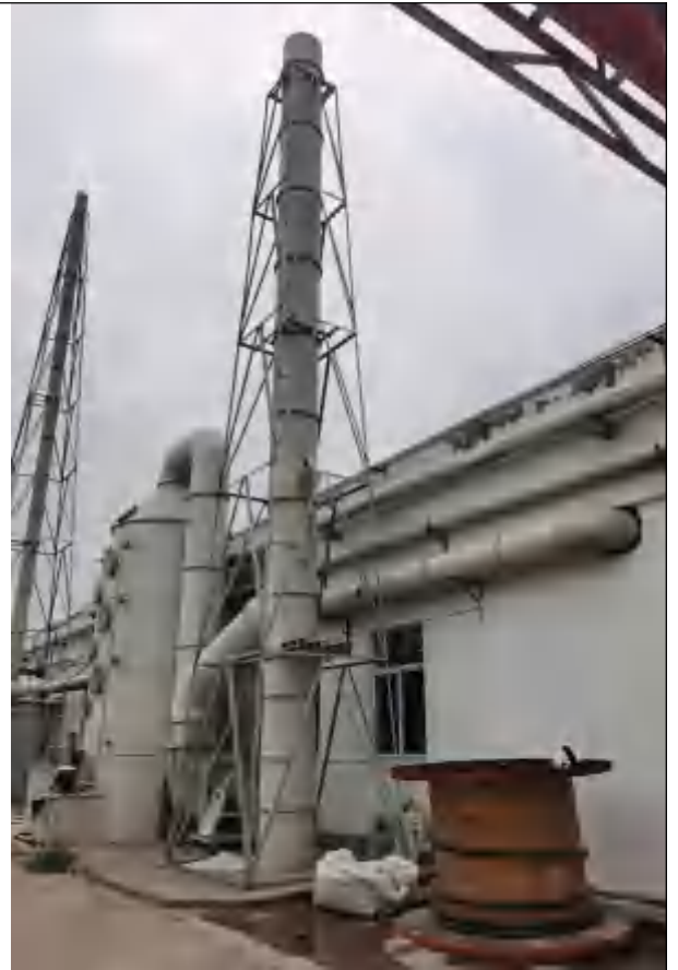
硫酸雾废气排气筒
