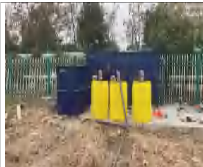
沉淀池和中和池
