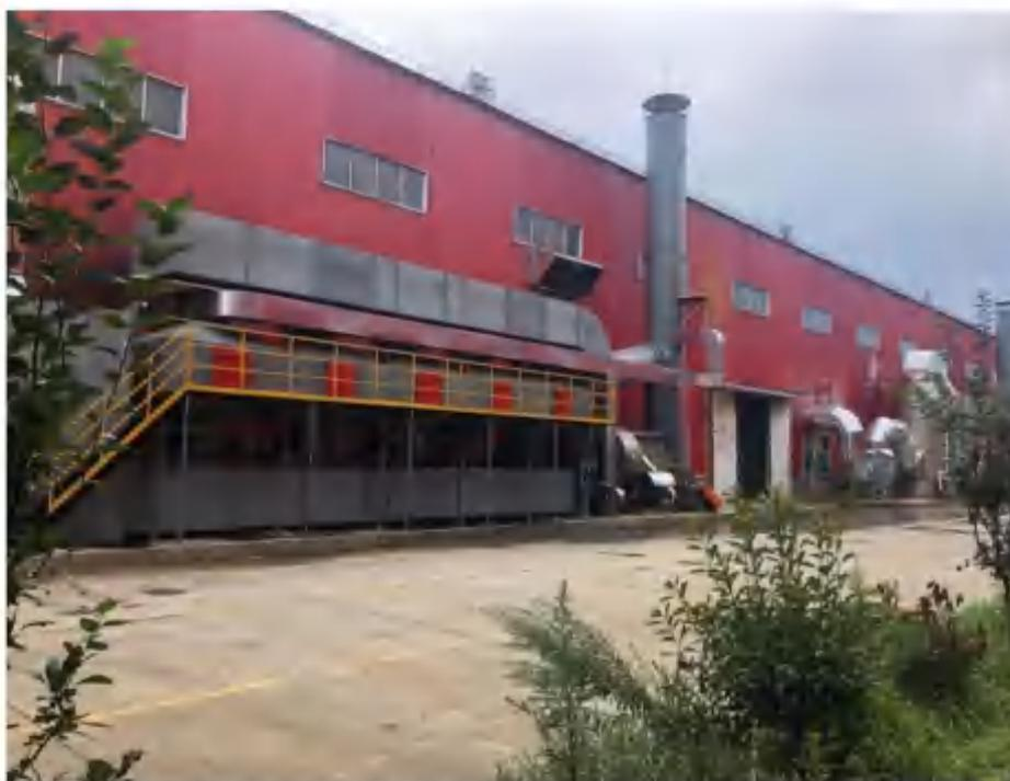
根据用户提供数据结合上表工艺类比可知，此类废气属于小风量、浓度低、常温挥发性有机废气；根据我公司长期治理废气的经验，对于小风量、低浓度的有机废气宜采用物理方法——干式过滤+吸附浓缩+脱附再生工艺处理，工作原理为有机废气中的有机溶剂经过吸附剂层被吸附浓缩，吸附饱和后用催化燃烧焚烧炉产生的热能使有机溶剂达到沸点使之挥发出来，此时挥发出来的气体为浓度高、风量小的有机溶剂再经催化燃烧低温催化裂解处理，同时产生热能（有机物分解放热）回用于吸附剂脱附再生；如直接采用冷凝、焚烧或催化法，从投资、能耗及运行成本都都很高；低浓度VOC通过吸附剂吸附浓缩，干净的气体达标排放，净化效率可达90%以上，吸附剂目前有活性炭和沸石分子筛等；当吸附一段时间后吸附剂会饱和，此时用高温热空气对吸附剂进行加热，使浓缩在吸附剂上的高浓度VOC达到沸点挥发出来成为小风量、高浓度有机废气进行催化燃烧，同时燃烧产生的热量可回用于脱附再生，循环利用，节能环保。本技术方案综合投资及运行成本的经济性拟采用喷淋+蜂窝活性炭吸附浓缩+催化燃烧装置再生脱附工艺，供贵公司领导及相关负责人参考审查；
